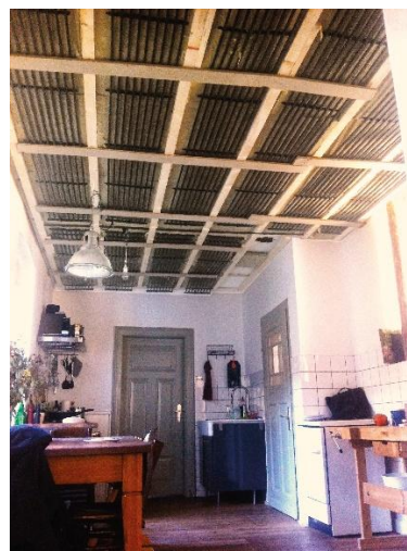
Bild 7: Küche in der Bauphase
