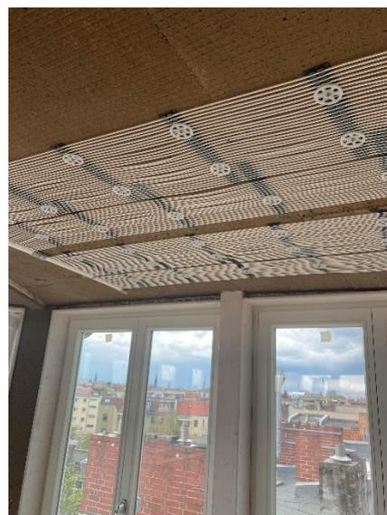
Bild 8: Deckenheizung für Lehmputz u.a. Putze
