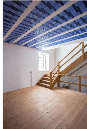
Bild 1: Kapillarrohrmatte für flache Aufbauten 3,5 mm Rohrstärke
