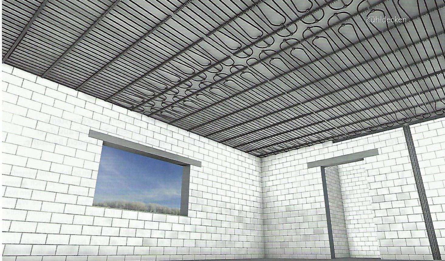
3 Der Nasseinbau unter der Decke ist ebenso möglich wie eine Trockenverlegung.
