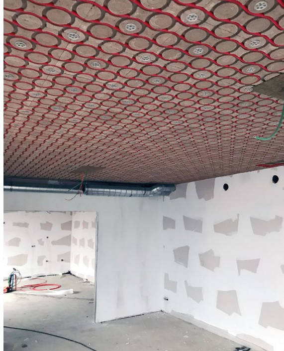
Bild 3 • Montage der Lehmmodule auf einer Unterkonstruktion direkt an der Decke.
