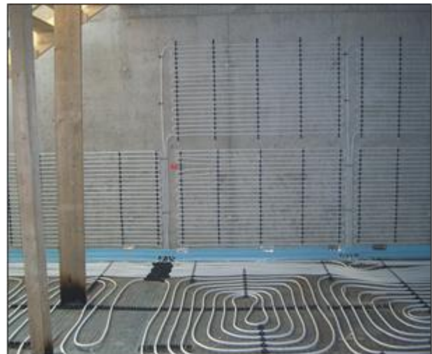
Bild 10: Beispiel einer Kombination von Wand- und Fußbodenheizung
