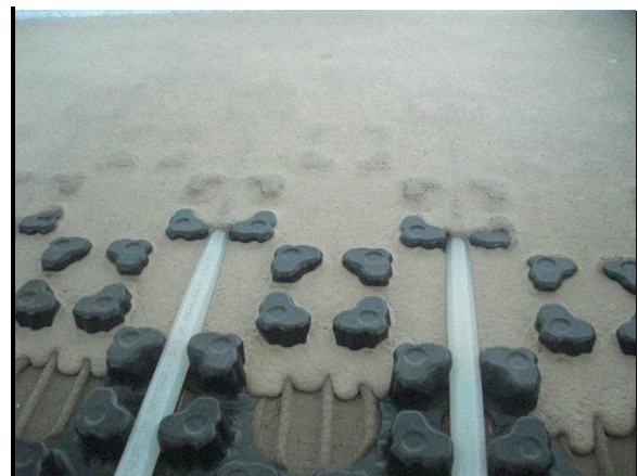
Hier sind Planer und Architekten besonders gefordert, eine unerwünschte Wärmeabgabe
