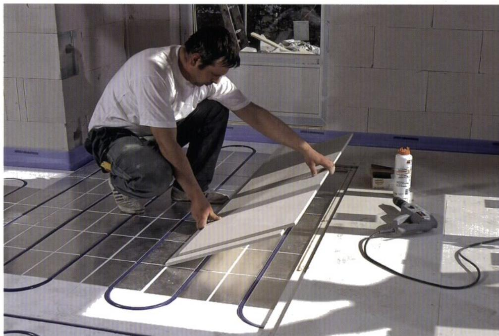
Spezielle Heizungssysteme mit niedriger Aufbauhöhe erlauben den Einbau einer Fußbodenheizung im Bestand. Systeme im Trockenestrichaufbau lassen sich z.B. auf Holzdecken einsetzen.
