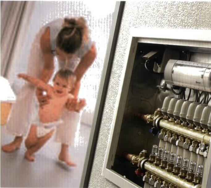
Der Heizkreisverteiler sorgt für die gleichmäßige Verteilung der Wärme in den einzelnen Wohnräumen. Ein hydraulischer Abgleich ist, wie bei jeder modernen wassergeführten Heizungsanlage, unabdingbar.
