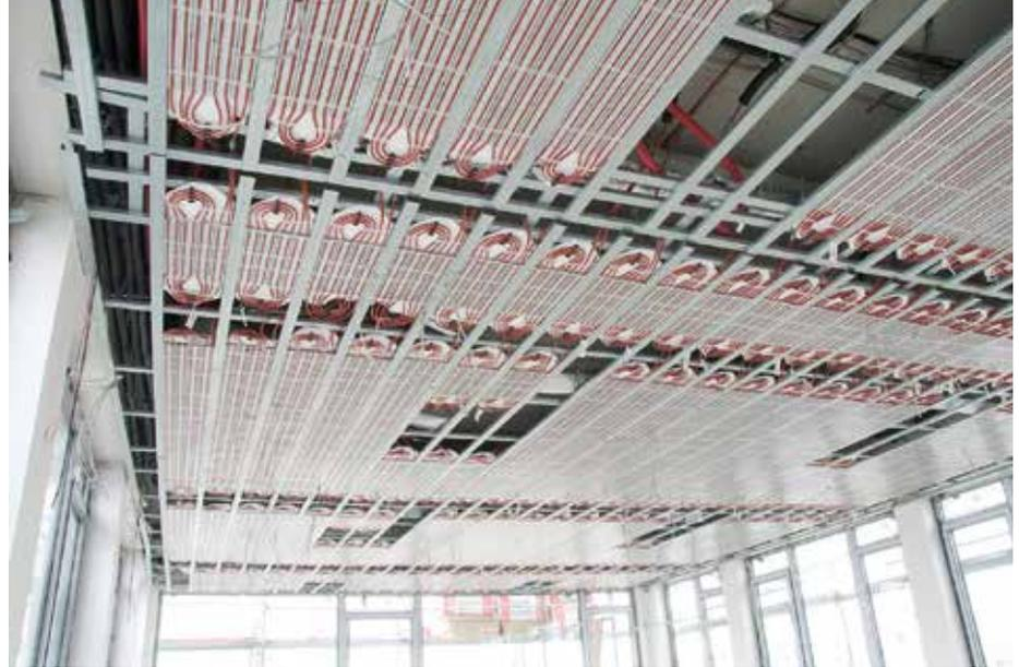
Raumkühlung über eine abgehängte Decke. Gerade dieses Beispiel zeigt, dass ein hydraulischer Abgleich enorm wichtig ist.
