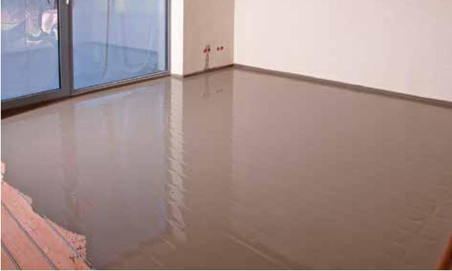
Die wasserführenden Rohre werden z. B. in Noppenplatten eingelegt und dann mit einer Vergussmasse bedeckt.
